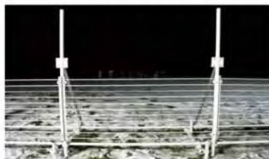
(b) 遮蔽フェンス工事写真
