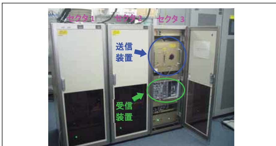
図 1.1.15 セクター型アンテナ用送受信局の外観（3 セクター分）
