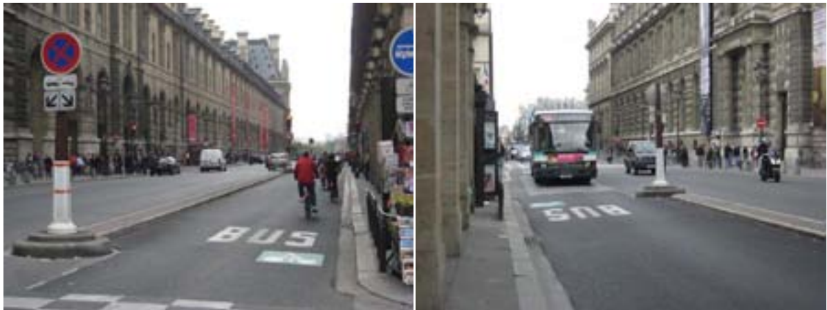
バス専用レーンは分離帯で完全に仕切られている
