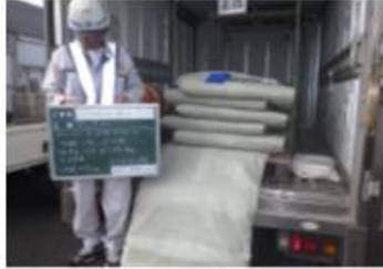
既設管の中に挿入する袋帯状の材料(高温で固化する合成樹脂製)
