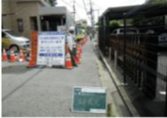
工事区間の状況
