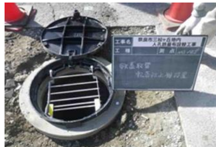
新しいマンホール蓋は必要に応じて転落防止柵を設置
