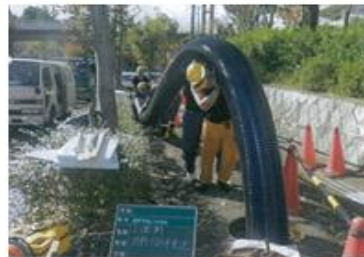
既設管に新たな管を挿入
