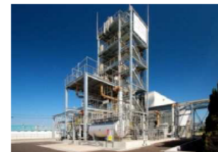
有害化学物質の放出を抑制可能な二酸化炭素分離回収設備
