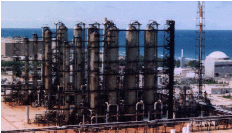
Figura 2.5. A Planta de Água Pesada de Ontario Hydro International Bruce Point tem capacidade de produzir 800 toneladas por ano. Foi desativada em 1997. Oito plantas deste porte podem suprir suficiente água pesada para gerar toda a energia atualmente consumida no mundo.
