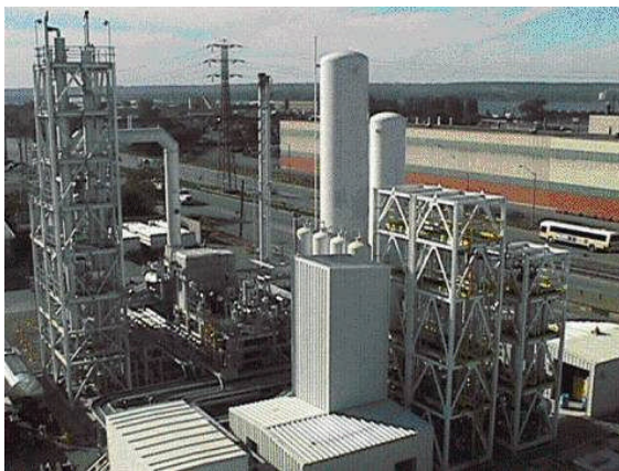
Figura 2.6. Atomic Energy of Canada Ltd. planta piloto avançada de água pesada, Hamilton, ON. Foto cortesia da Atomic Energy of Canada Ltd. Esta planta produz cerca de 1 tonelada de água pesada por ano. Uma versão aumentada dela seria mais eficiente e limpa que a velha planta de Bruce Point acima.
