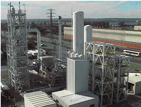
図 2.6. カナダ原子力公社、先進重水試験的生産工場、ハミルトン、オンタリオ州。この工場は 1 年間に約 1 トンの重水を生産した。大規模にすれば図 2.5 の古い工場より効率が良くて公害が少ない。写真はカナダ原子力公社提供。
