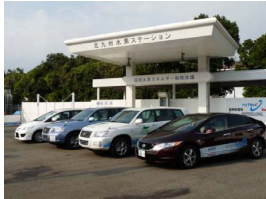
図 6.3.2-2 北九州水素ステーション
