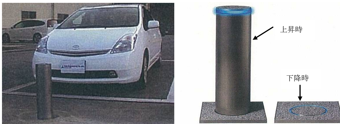
図 3.2.4.1 誤発進防止対策設備例
