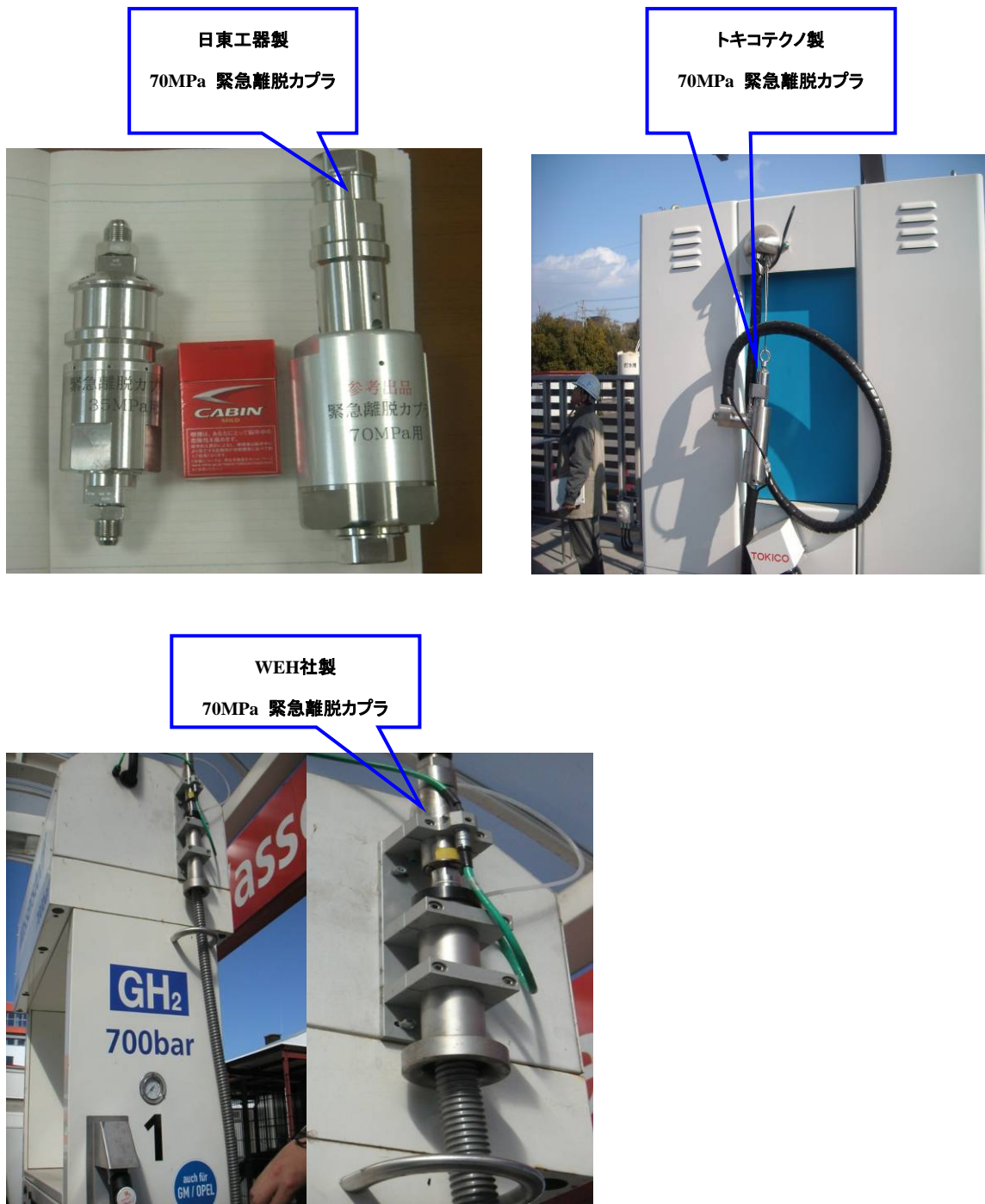
図 3.2.4.2 誤発進トラブル対策(緊急離脱カプラ)事例
