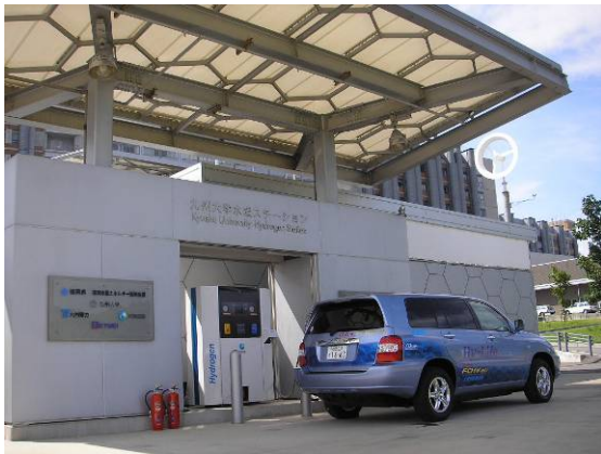
図 6.3.2-1 九州大学水素ステーション
