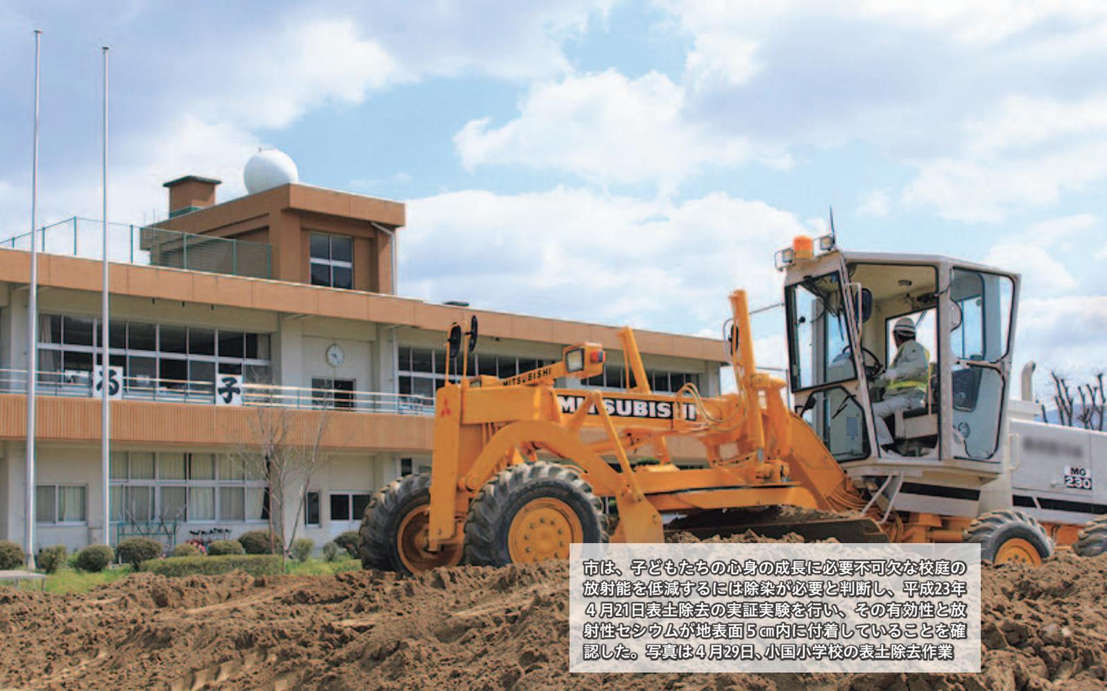
市は、子どもたちの心身の成長に必要不可欠な校庭の放射能を低減するには除染が必要と判断し、平成23年4月21日表土除去の実証実験を行い、その有効性と放射性セシウムが地表面5cm内に付着していることを確認した。写真は4月29日、小国小学校の表土除去作業
