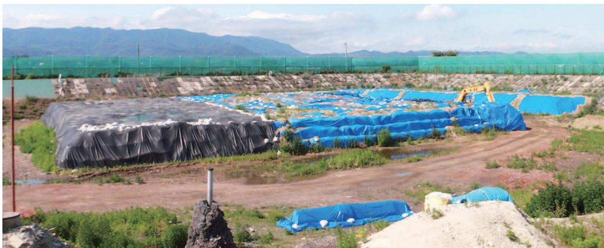
主灰と飛灰に分別したフレキシブルコンテナは、管理型最終処分場内にペントナイトシートを敷いてその上の指定された位置にそれぞれ仮置きし、1段ごとに覆土しながら3段まで積み上げて最後に黒い遮水シートで覆い管理している(写真提供:伊達地方衛生処理組合)
