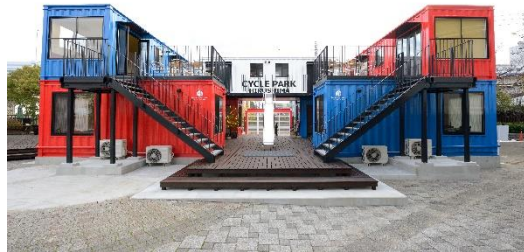
コンテナハウス外観
