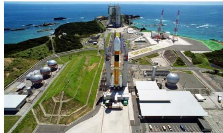
種子島宇宙センターには、第1射点(静止2トン級衛星の打上げに対応)と、第2射点(静止2~4トン級衛星の打上げに対応)の2つの大型ロケット発射塔が整備されており、ここでH-IIAロケットの打上げが行われる。
