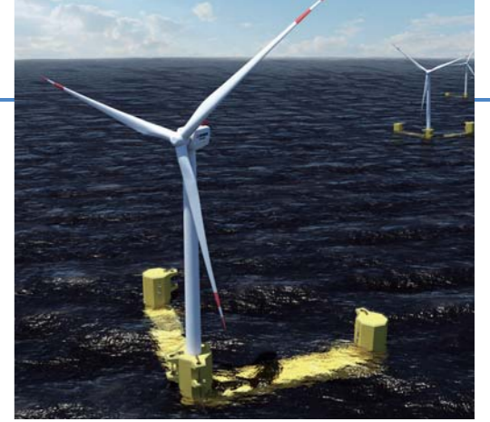
福島県沖の実証研究事業に使用される浮体式風車(イメージ)
