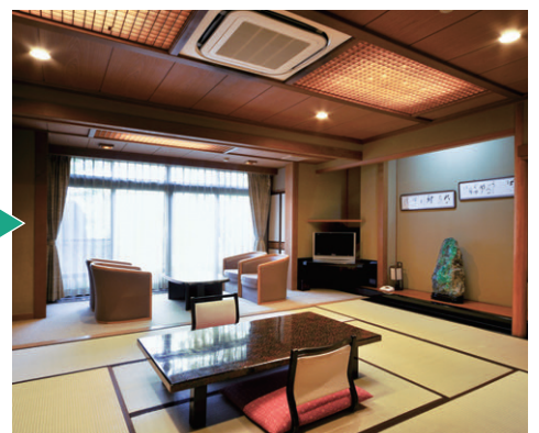
LEDダウンライト600シリーズに更新された西殿客室の照明
