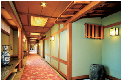
廊下の照明 光源をLED電球及び高効率蛍光灯ランプにし、人感センサーを設置して人が通る時のみ点灯
