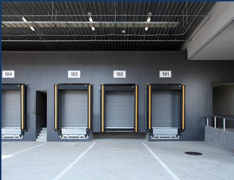
水産卸売場棟1階
