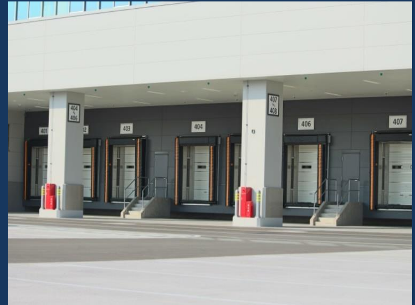
水産卸売場棟4階
