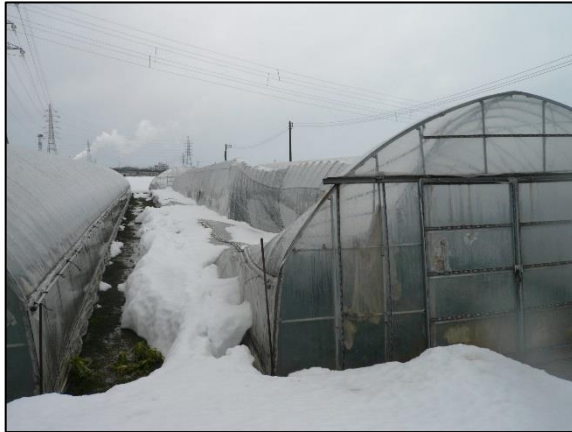
倒壊したハウス
