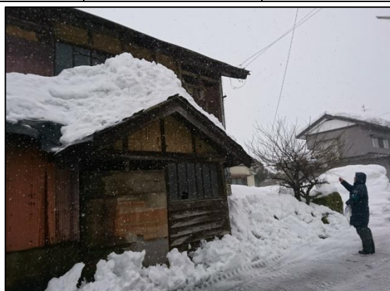
勝山市：不在家屋の危険箇所の目視点検（2/11）
