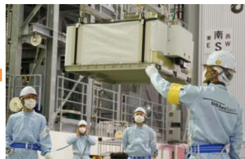
バッテリーの移動作業*2
