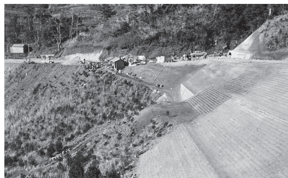
実験場正門付近の工事風景
