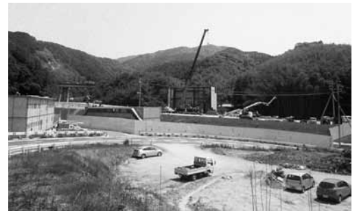
大型プロジェクトの受注となった「見坂工区トンネル工事」
