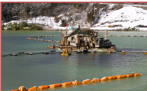
ダムの浚渫(群馬県)
