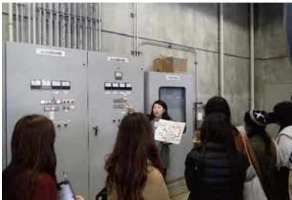
中央設備機械室で説明中
