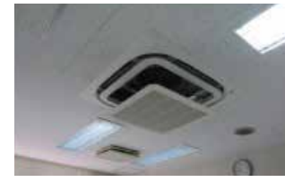
天井カセット型エアコン & 自動昇降パネル
