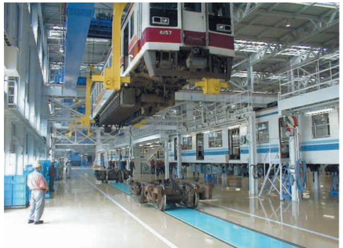
車体分離：レール下に設置されている車両自動搬送装置で車両を移動後、クレーンで分離
