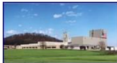
WECサービスセンター 米国ペンシルバニア州ウォルツミル
