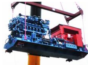
機器補修・据付
