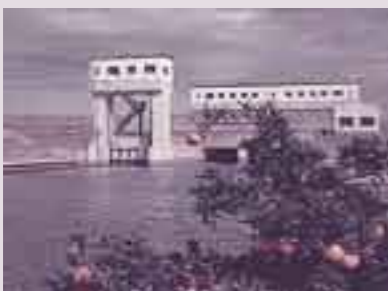
勢濃排水樋門
