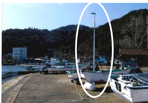
設置されたLED照明灯
