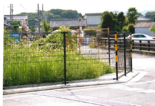
新たに設置されたフェンス
