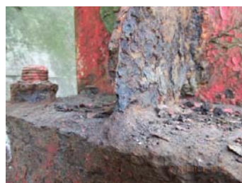
アーチ基部の補剛材の断面減少
