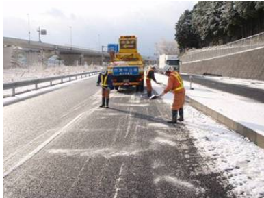
凍結防止剤散布状況
