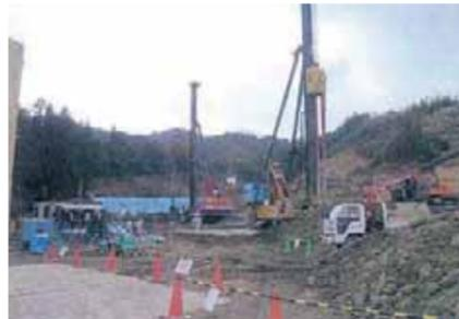
地盤改良工事(固結工)
