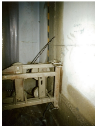
ワイヤーソー施工例
