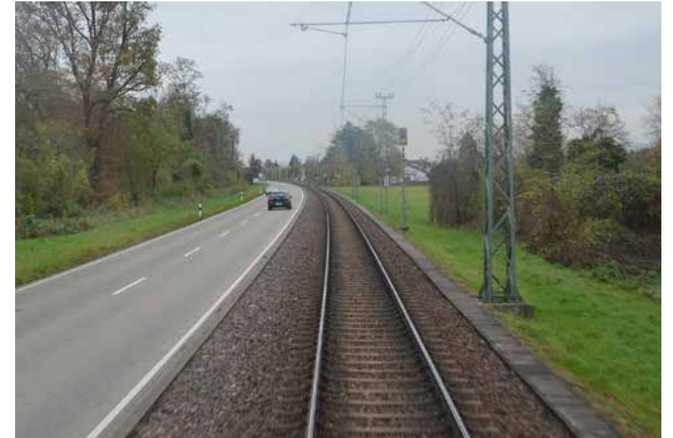
Kuva 45. Raitiotieväylä, Karlsruhe. Samaa tapaan Tampereen kaksirai- teinen raitiorata on suunniteltu sijoitettavaksi Hervannan valta- väylän läntisen ajoradan rinnalle.
