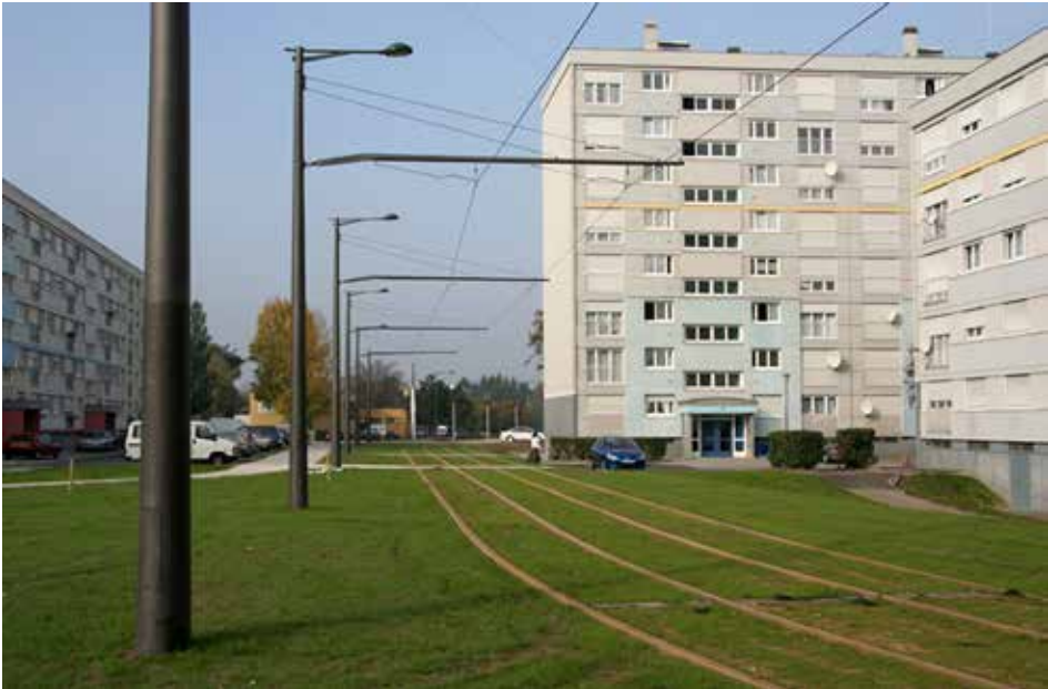
Kuva 54. Ajolankojen ripustus pylväissä radan yhdellä sivulla. Strasbourg.
