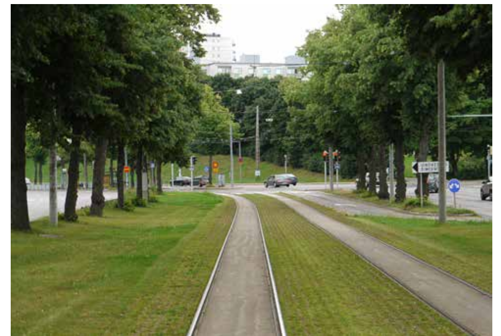
Kuva 46. Raitiotieväylä katupuiden keskellä ja ajoradat reunoilla, Helsin- ki, Mäkelänkatu. Samalla periaatteella on esitetty yleissuunni- telmassa toteutettavaksi Tampereen Teiskontien ja Sammon- kadun katutilojen järjestely.
