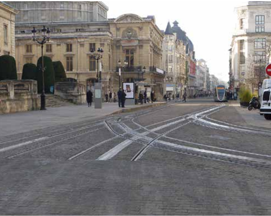
Kuva 32. Vaihteet rakennettuina valmiiksi tulevaisuuden uuteen haaraan, Reims.
