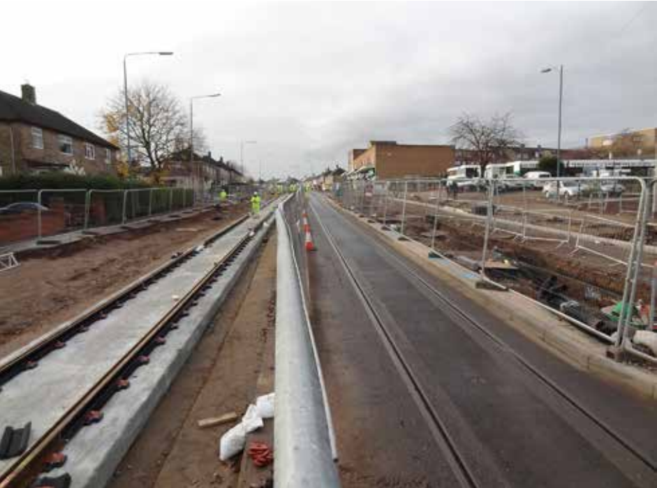
Kuva 60. Radan rakennustyömaa, Nottingham.
