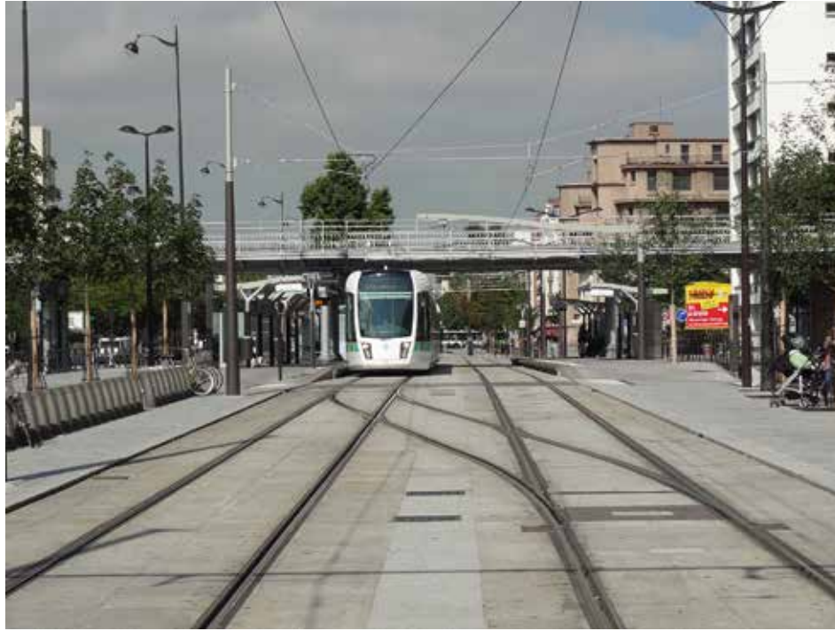
Kuva 48. Vaihteet ja kääntöraiteet päätepysäkin yhteydessä, Pariisi.
