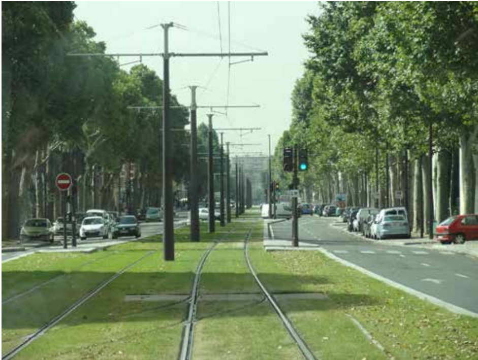
Kuva 53. Ajolankojen ripustus pylväissä radan keskellä. Pariisi
