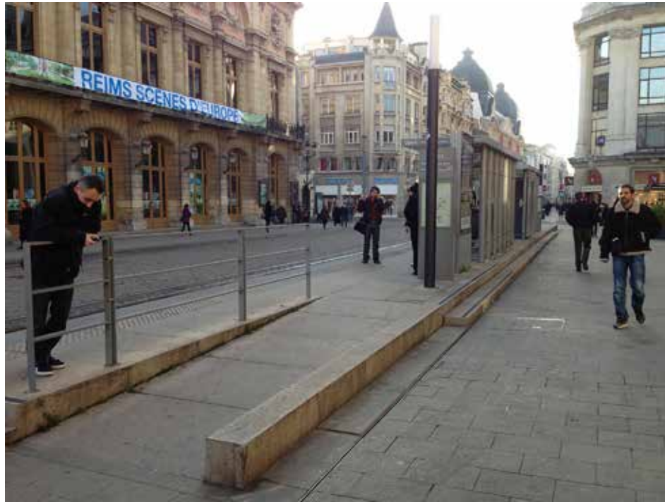
Kuva 34. Esteetön kulku pysäkille, Reims. Pysäkin päässä on rinnakkain luiska ja kapeampi laituriosuus.
