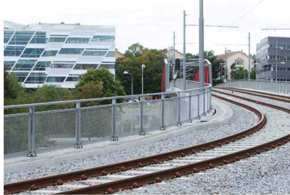
Kuva 50. Sepelipintainen rata, Tvärbana (kuva Olle Holdar)
