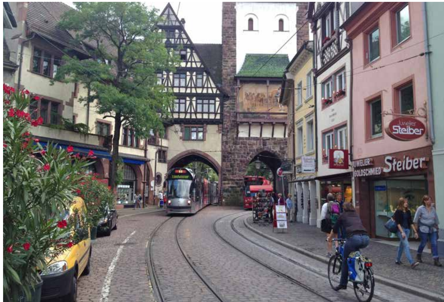
Kuva 44. Sekaliikennekaista kaupunkirakenteessa, Freiburg.
