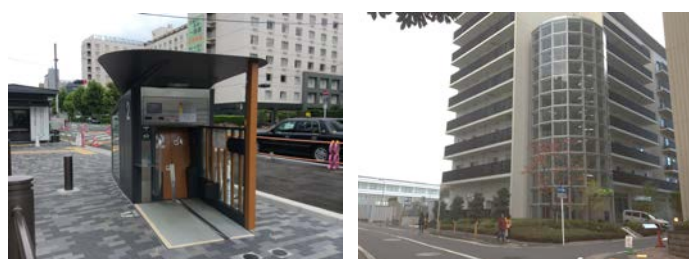
(京都市) (横浜市) 地下及び地上空間を活用した駐輪施設
