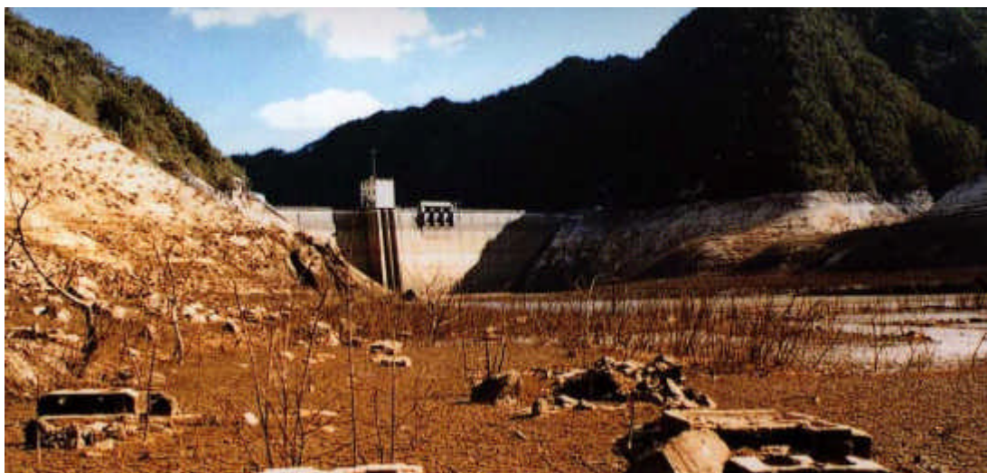
空になった宇連ダム
