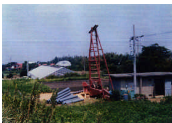
応急井戸掘り（平成6年9月）
