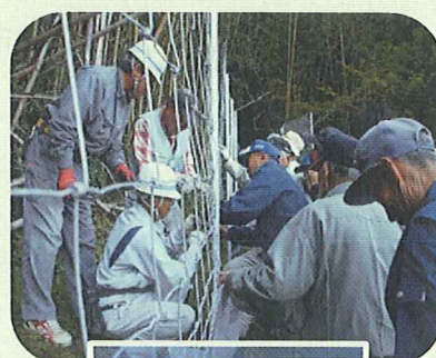
鳥獣害柵設置
