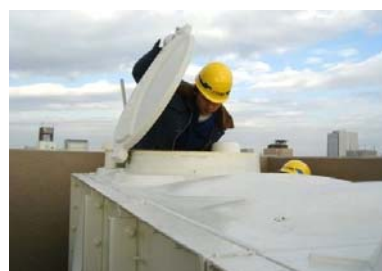
貯水槽水道の点検
