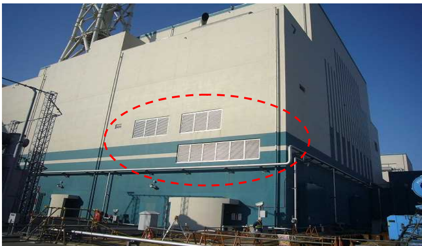
図 6-2 非常用ディーゼル発電機換気空調系の外気取入口
