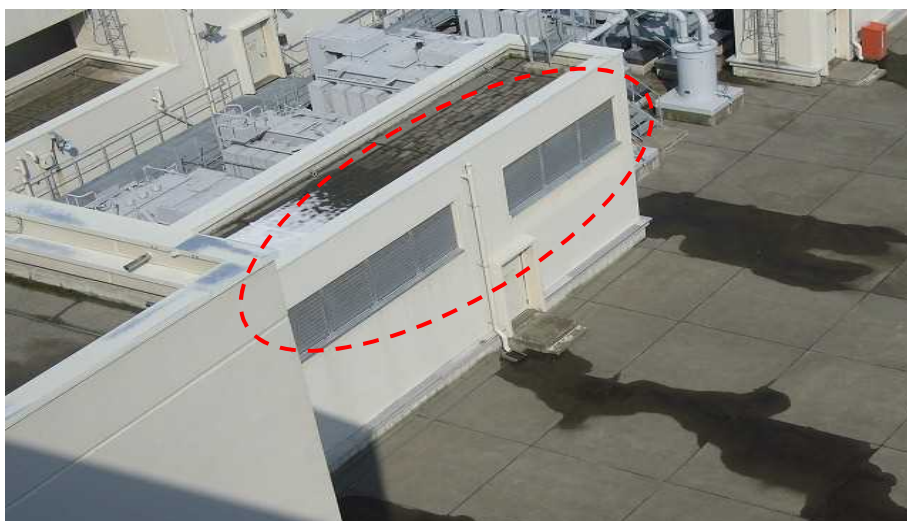
図 6-2 中央制御室換気空調設備換気空調設備の外気取入口
