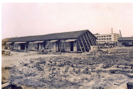
写真2 白島小学校のバラック校舎
