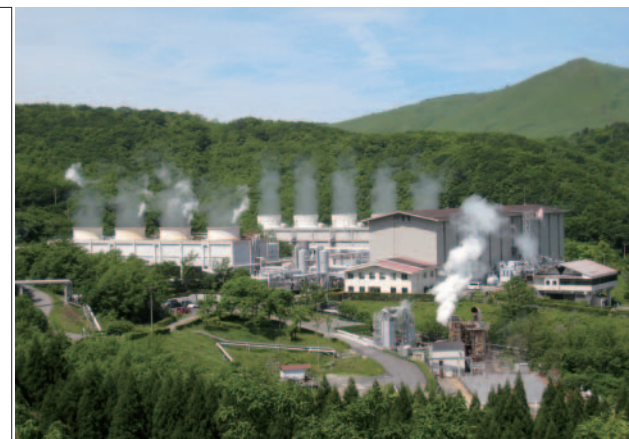
写真1 山々に囲まれた「八丁原発電所」
