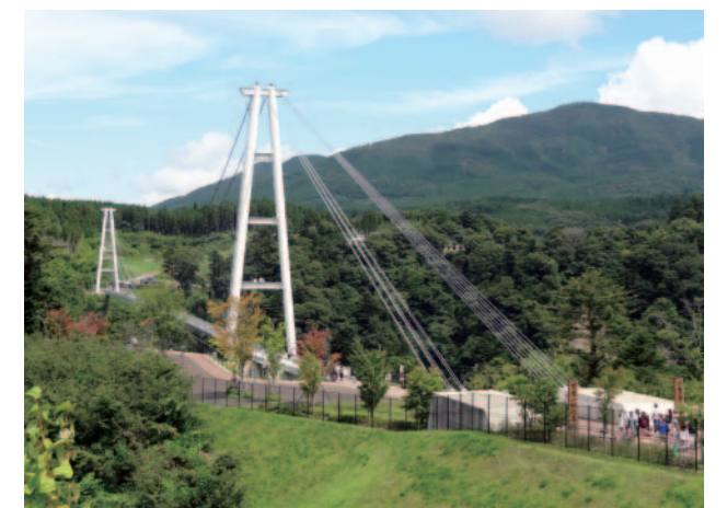
写真7 新緑と紅葉の名所・九酔溪に架かる「九重“夢”大吊橋」
