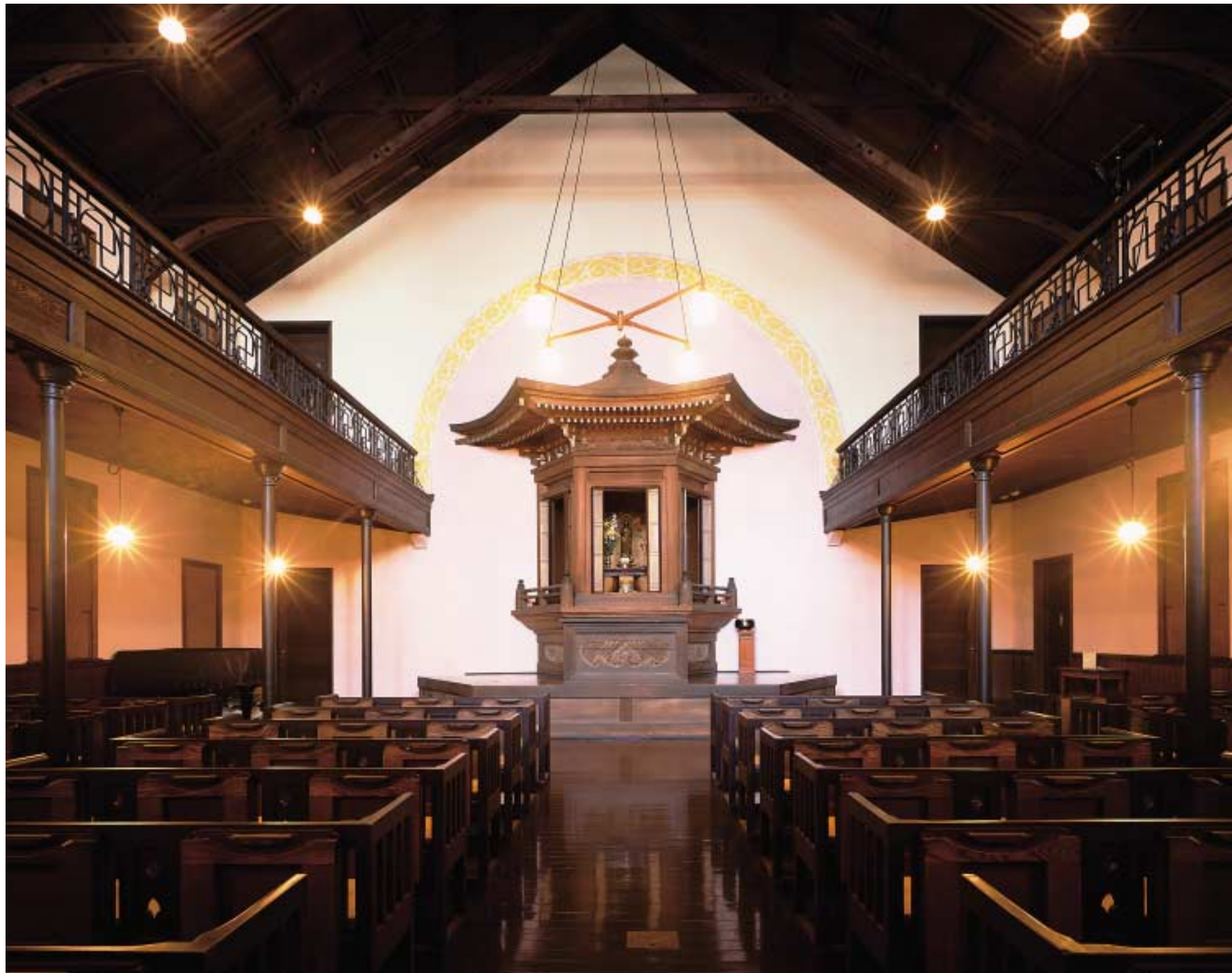
大会堂 明治36年に設計に着手したが、工費難などから2度にわたって設計変更を行なっている。いすを用い、ハンマービームトラスの小屋根を現しにして、周囲にギャラリーを巡らすというキリスト教会堂的な骨格であるが、そこに六角形の厨子を壁から突出させ、卍文様の高欄を配して、特異な空間を現出させた。この無国籍性は、しかし求道学会の創設者である近角常観が推進する仏教運動の革新性と照応する
