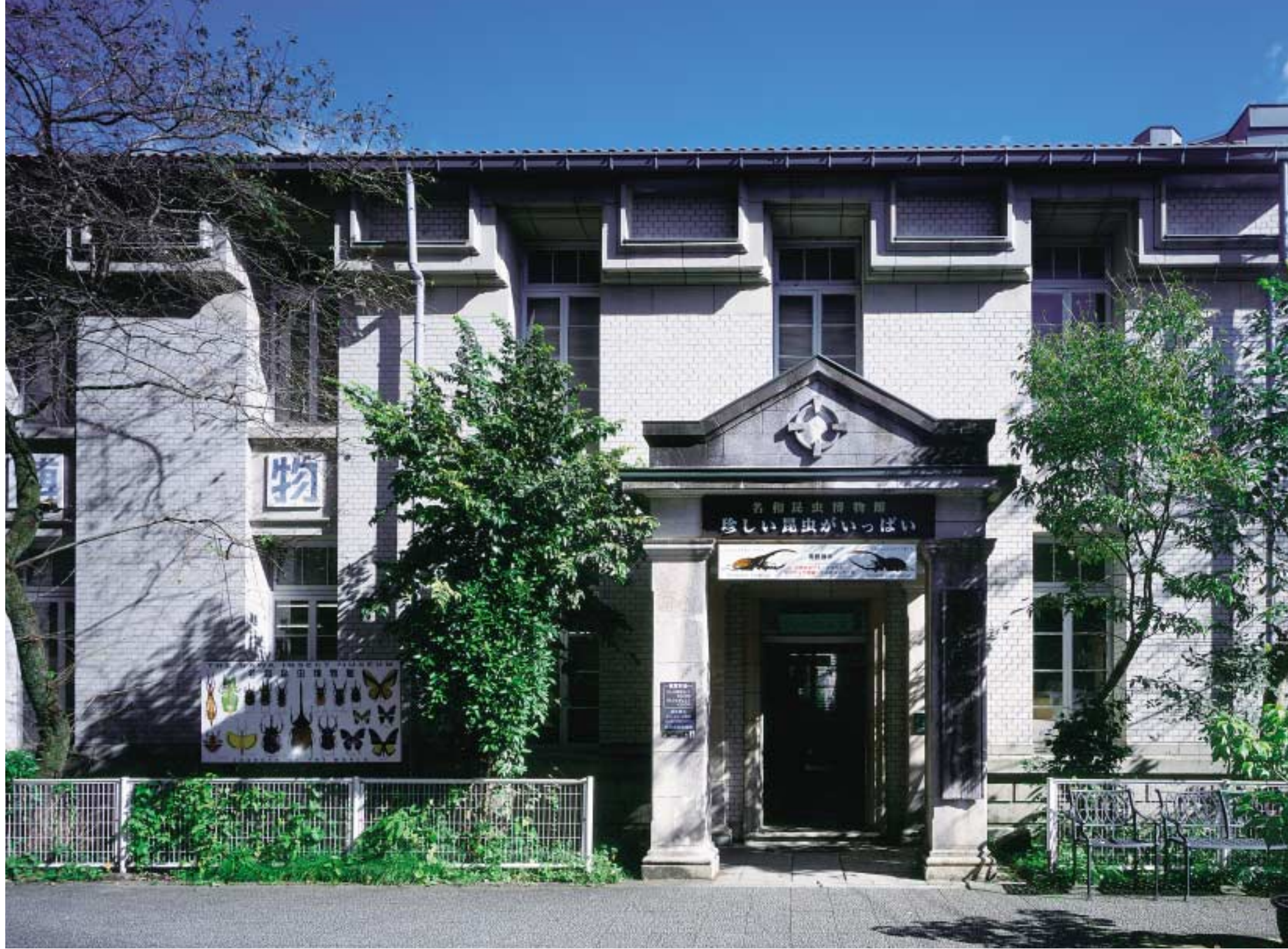
博物館正面外観 名和靖の遺願を記念して建設されたもの。あらゆる要素が直線と直方体へ還元されている観があり、1910年代のP.ペーレンスに適するものがある。一方で、車寄は様式的であり、次第に折衷性を強める傾向をうかがわせる。京都高等工芸学校での教え子である古武東里（1886～1945）が実施設計を担当したことが分かっている
