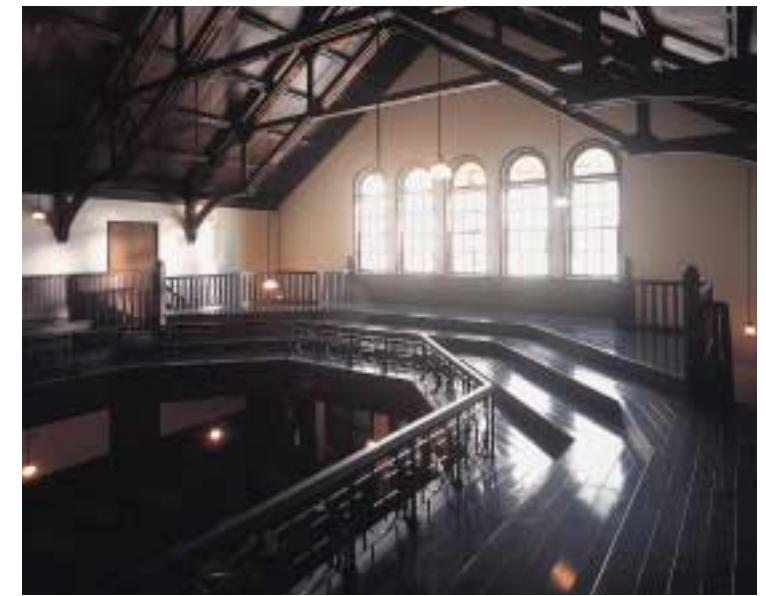
大会堂2階ギャラリー 菩提樹を描いたステンドグラスの平明なデザインと、ボルトを殊更に強調したトラスの力感とが不思議な調和を見せる。ギャラリーは当初は畳敷きだった
