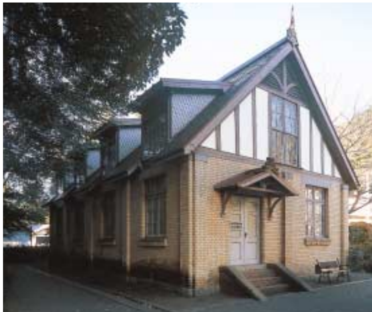
記念昆虫館南西面全景 単純化された形態に、この時期の五一の関心がよく表れる。特に屋根窓のガラス面を外壁と同一平面で納める手法は、今見ても斬新。屋根の破風板は当初は削形（くりかた）が施されて、より装飾的だった
