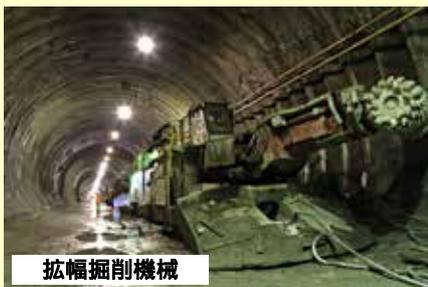
拡幅掘削機械
