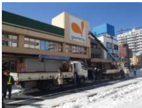
商店街のアーケード落下物撤去状況 場 所：八幡町（本郷横丁東）付近
