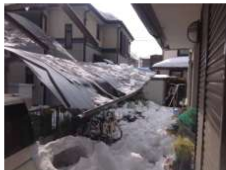
住宅街でのカーポート被害 場 所：元本郷町
