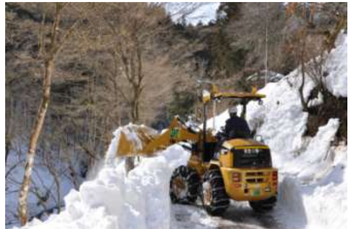
19日（水）13時ごろの除雪中の様子 場 所：上恩方地区
