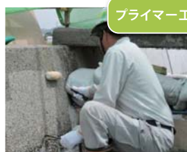
プライマー工
