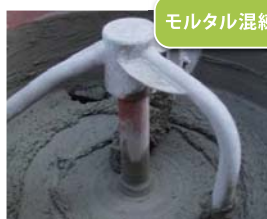
モルタル混練
