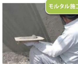
モルタル施工
