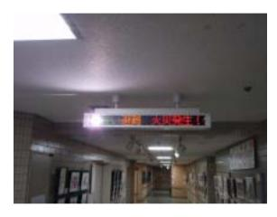
自動火災報知設備と連動して、 火災情報を「文字」とキセノンフ ラッシュで確実に伝達します。
