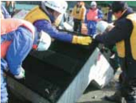
網状構造培地とコンクリートブロックを組み合わせ、厚岸沖に投入した藻場再生実験
