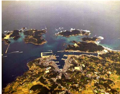
【現況写真】(長崎県土木部港湾課)
