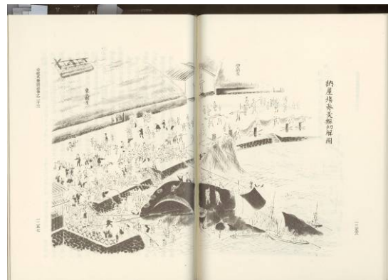
【田ノ浦くじら解体作業】
