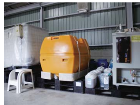
寺の北側にある「祭器庫」に設けられたEM活性液の培養プラント。寒い奈良の冬でも発酵が進むように給湯機まで完備されています。
