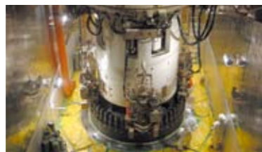
原子炉压力容器上蓋の取り付け作業
