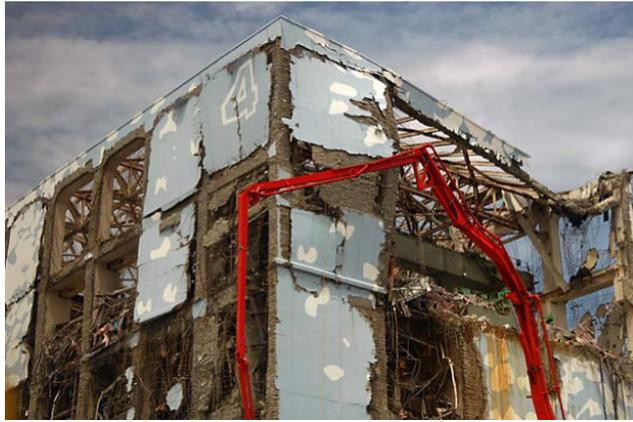
図 3.4 爆発で外壁の吹き飛んだ福島第一原子力発電所 4 号機の様子（写真は IAEA (fact finding team) による）。
