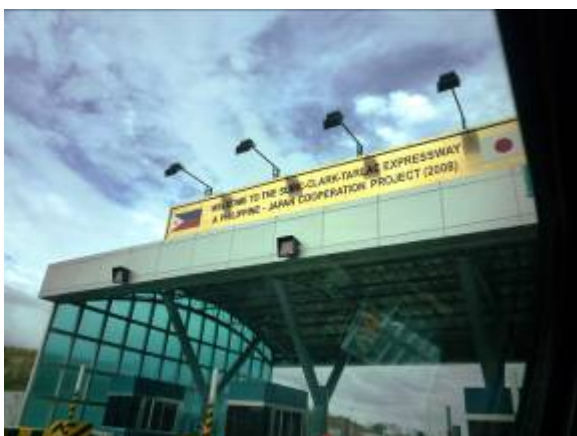
クラーク地区とを結ぶ高速道路入口
