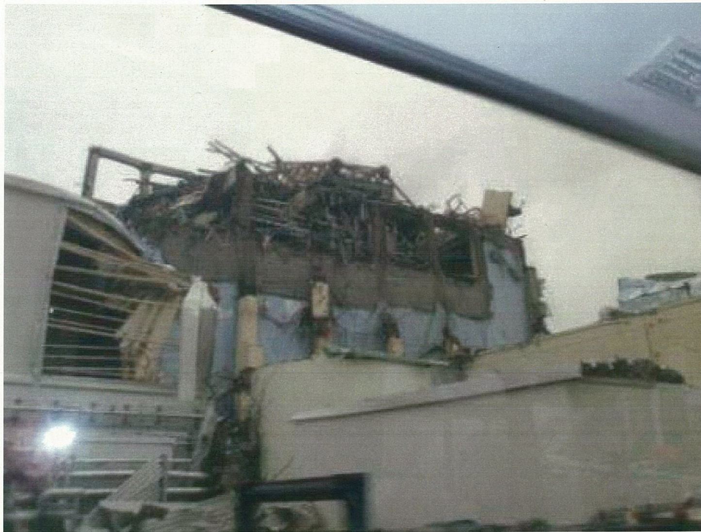
(7)現場視察5(4号機下)
