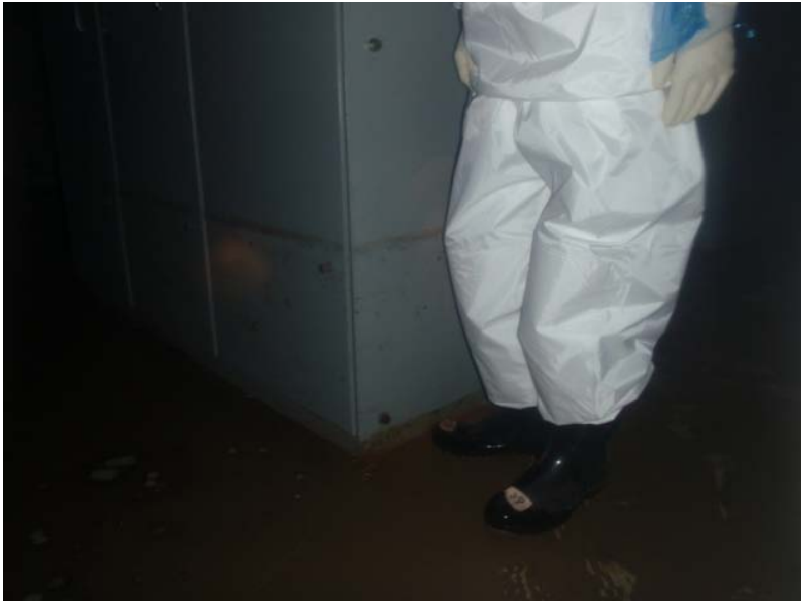
(5) 地下一階の状況(浸水跡)
