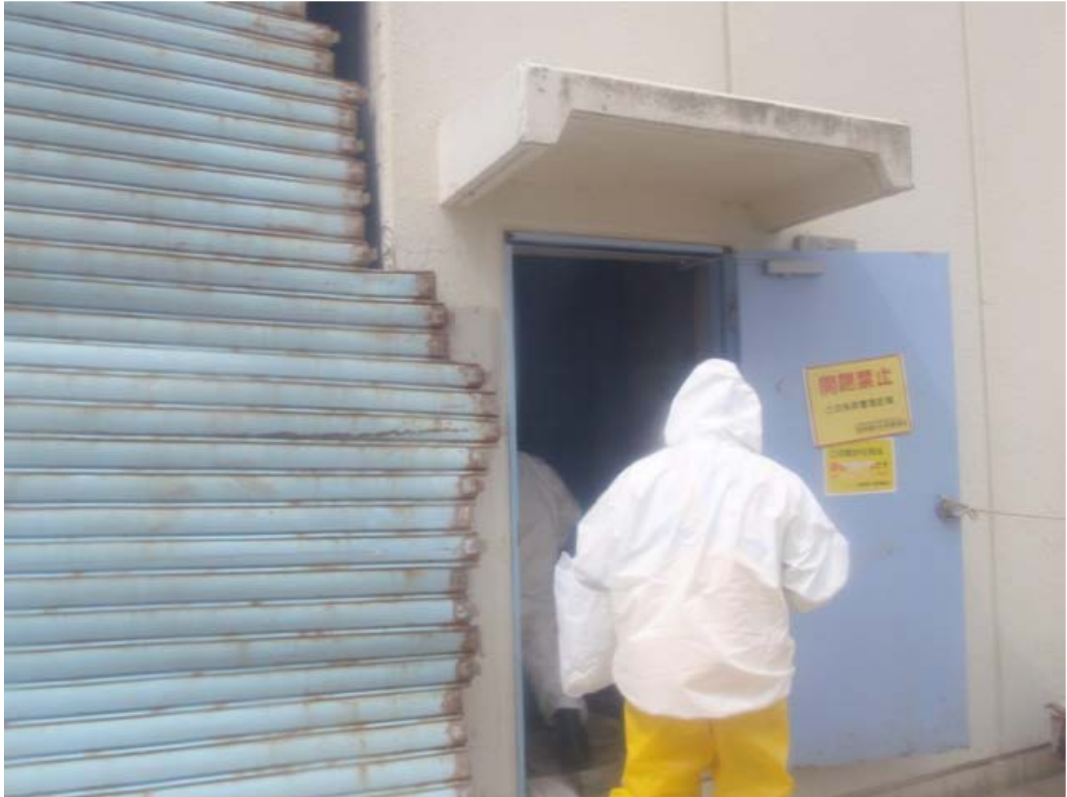
(1) 入口付近の状況
