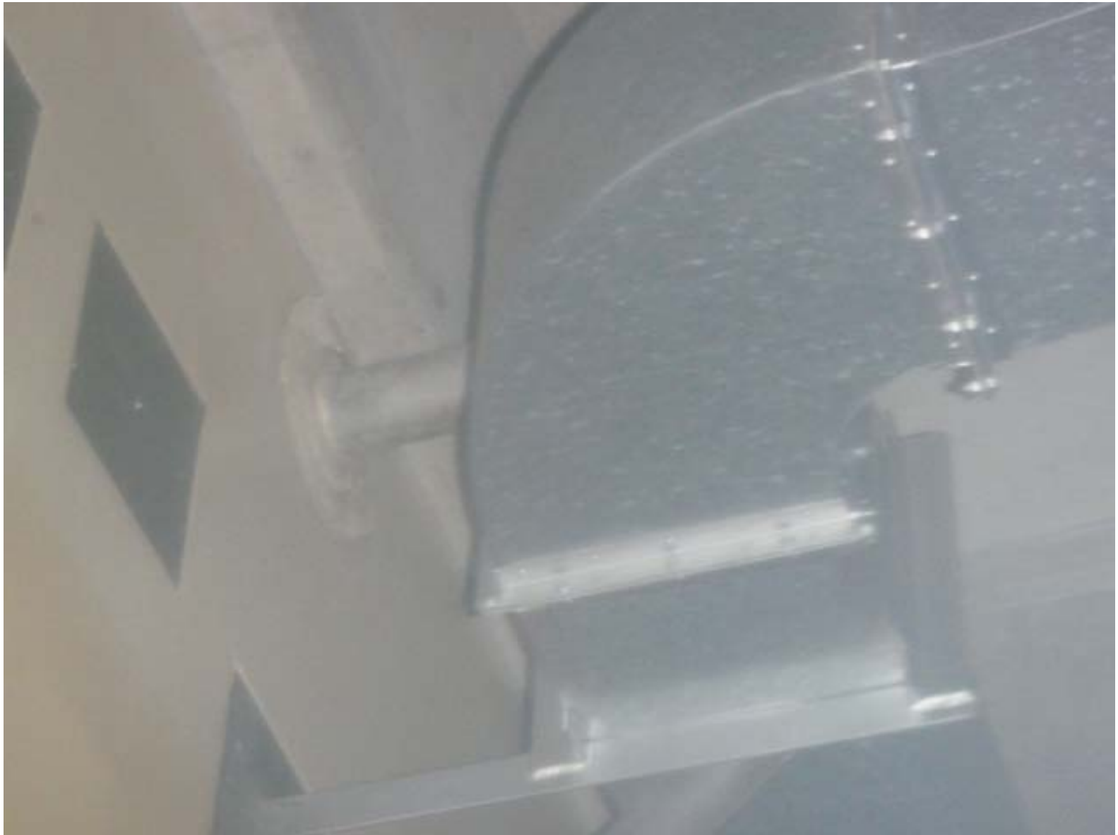
(4) 配管貫通部の状況
