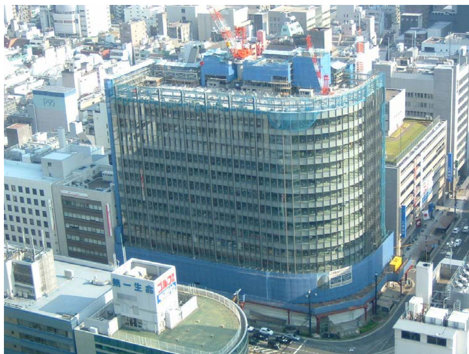
現況工事写真（2011年6月3日撮影）
